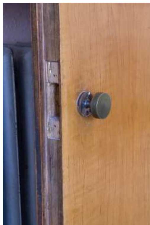
Detail kulové kliky a chybějícího zapadacího mechanismu
