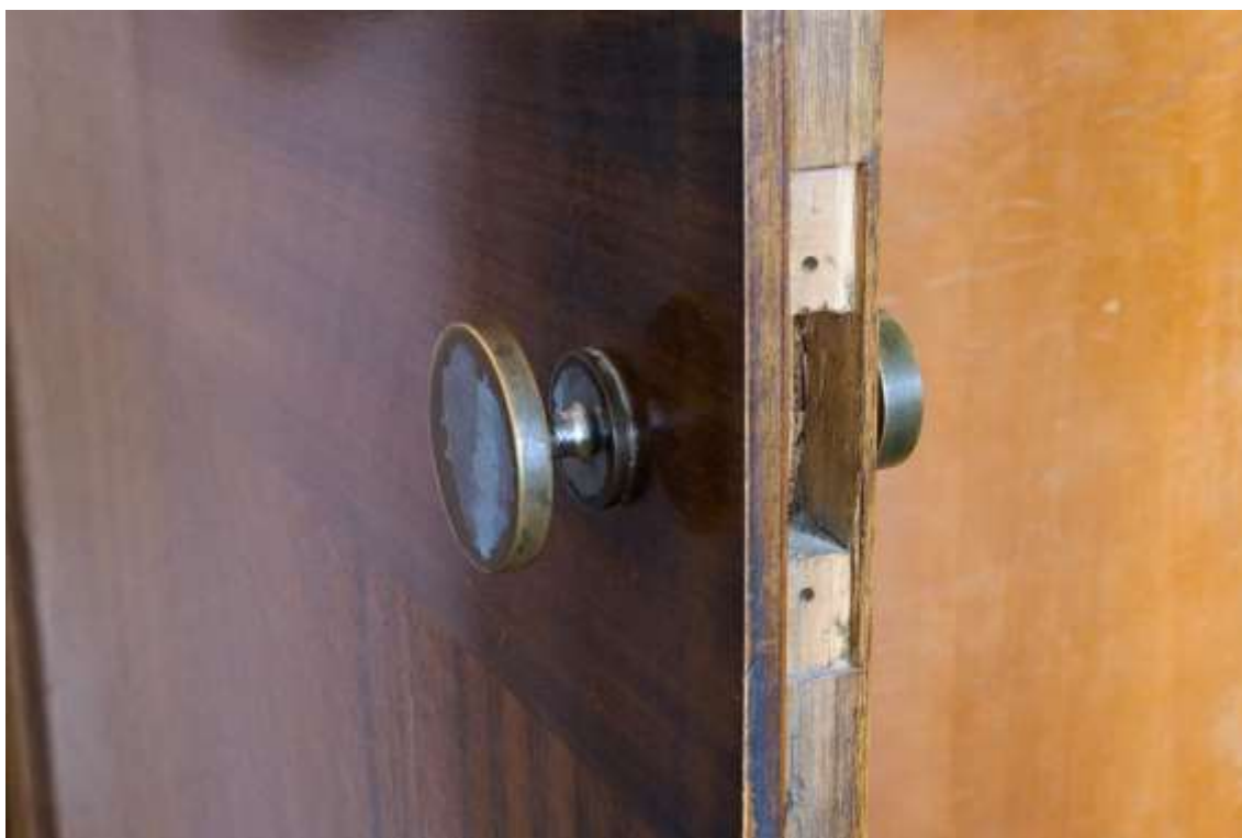
Detail kulové kliky a chybějícího zapadacího mechanismu
