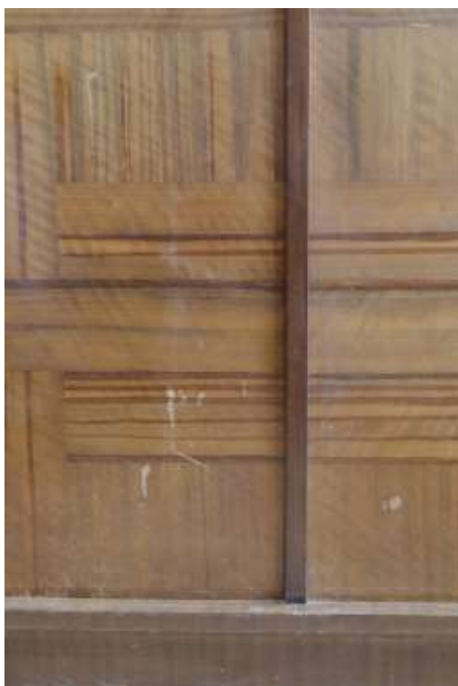
Detail poškozené povrchové úpravy a domalované kresby dřeva
